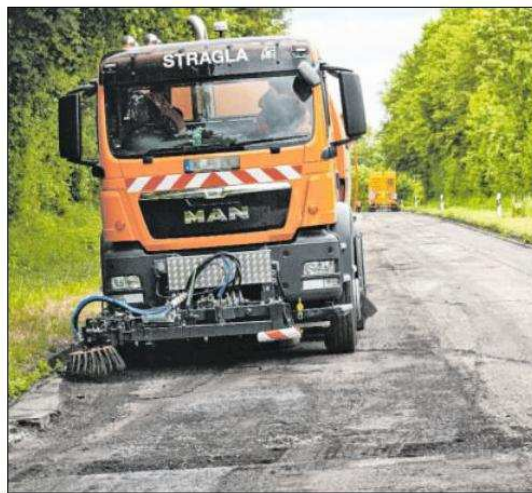
DER ALTE ASPHALT ist abgefräst, Splitter werden zusammengekehrt. Ab Montag wird neuer Belag aufgebracht. Foto: ml
