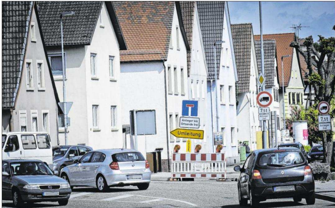
VON JÖHLINGEN HER ist die Landesstraße 559 in Richtung Weingarten nicht befahrbar, weil der Abschnitt zwischen Weingarten und Jöhlingen erneuert wird. Für Autofahrer bedeutet das eine Umfahrung über B 293, B 10 und B 3. Foto: wai
