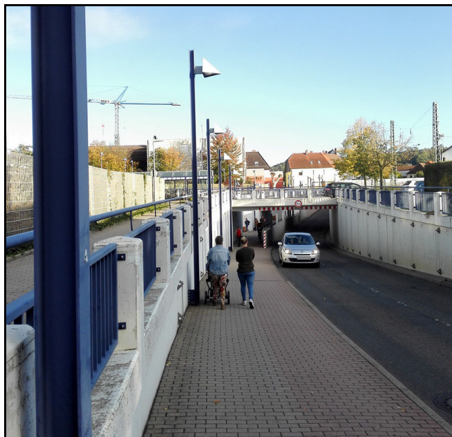
Abb. 1: Straßenunterführung, einseitiger Geh- und Radweg
