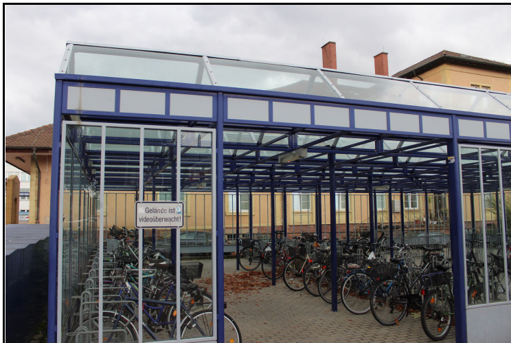
Abb. 2: Gesicherte, überdachte Abstellanlage Bahnhof Ost
