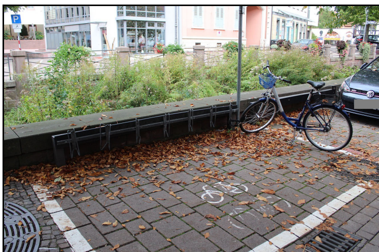
Abb. 4: Abstellfläche Ortszentrum, Vorderradhalter ohne Überdachung
