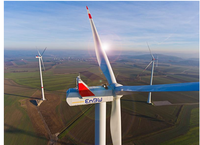
EnBW- Windpark Rot am See
