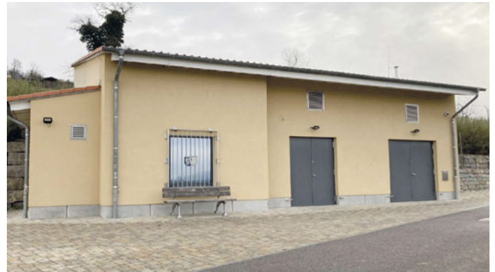
Der neue Hochbehälter am Katzenberg. Auch im Wasser- und Abwasserhaushalt sind weitere Kreditaufnahmen geplant - die Gebühren werden steigen.
