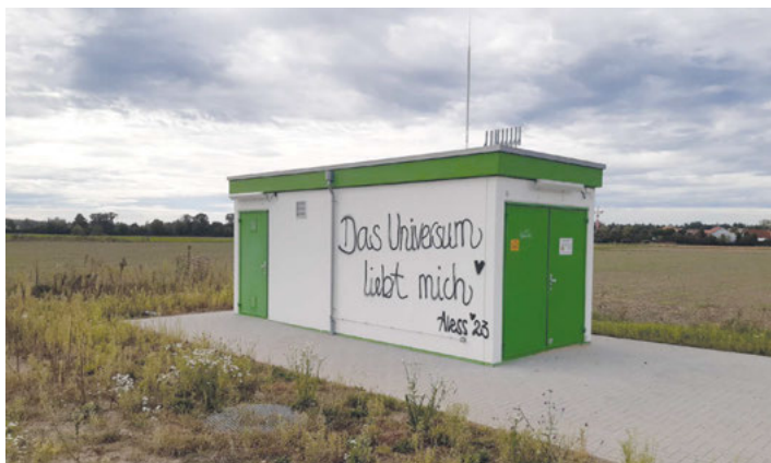
Allein auf weiter Flur - der Container für das Breitbandnetz im zukünftigen Gewerbegebiet Sandfeld
