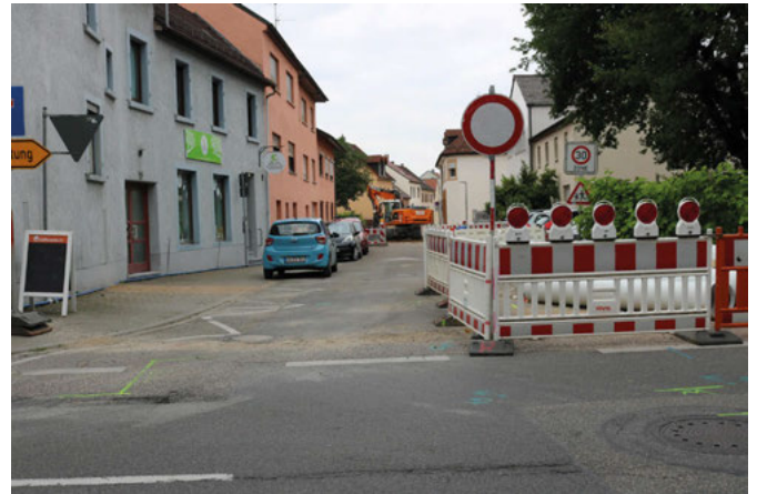
Der 3. Bauabschnitt der Schillerstraße
