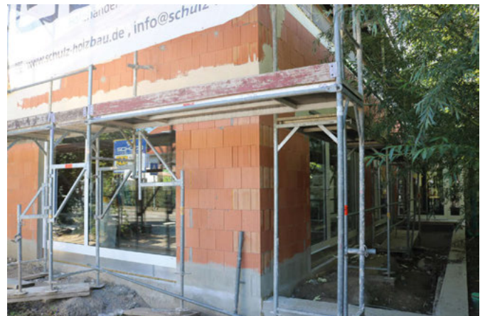
Der Anbau des Speiseraums an den Kindergarten St. Franziskus
