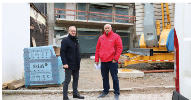
Bürgermeister Eric Bänziger (links) beglückwünscht den Bauherrn Dietmar Schulz zum Baufortschritt
