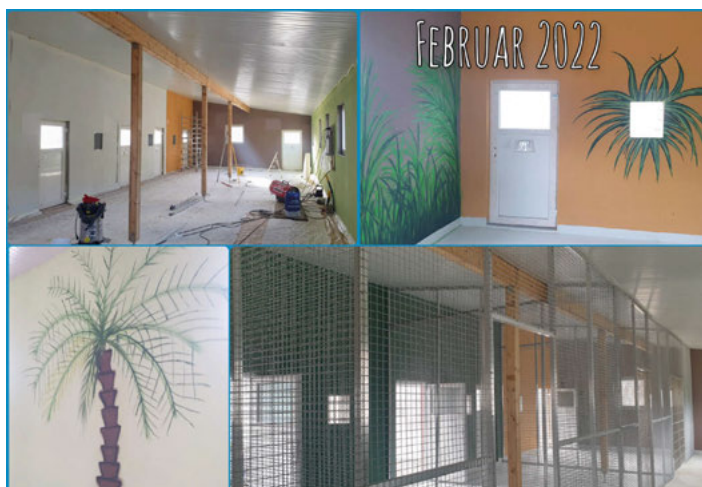
Auch der Innenausbau geht voran.
