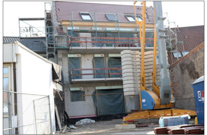
Auf der Rückseite des Hauses belichten Dachflächenfenster das Dachgeschoss
