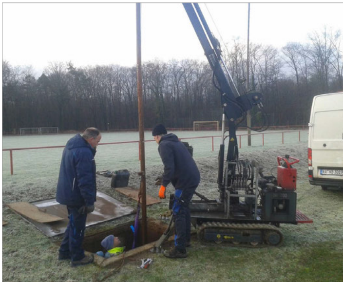
Das Team des Brunnenbauers bei der Sanierung
