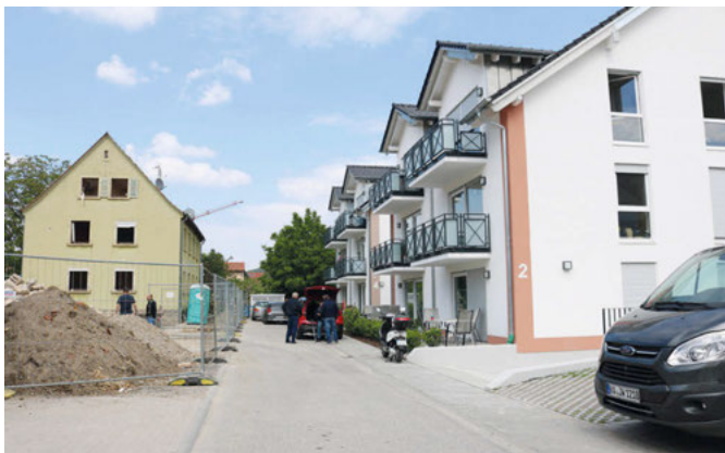
Die Mülbergerstraße im Wandel der Zeit: Auf der rechten Seite sind bereits die neuen Wohnhäuser realisiert, auf der linken sieht man noch die Altbauten aus 1950.
