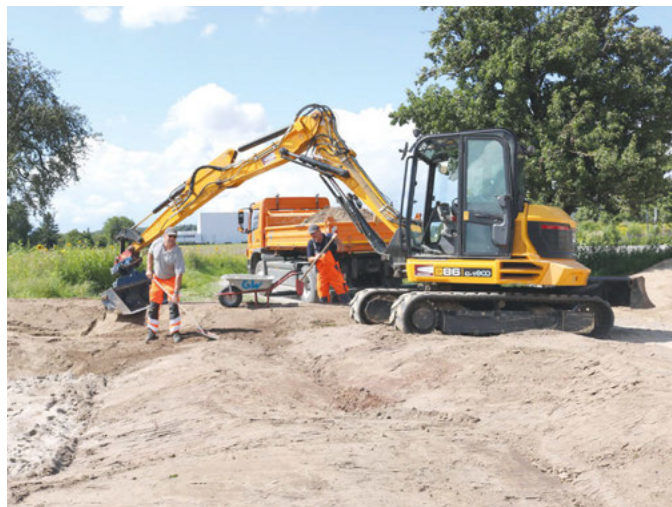
Foto (von links) Günther Hoffmann und Waldemar Hochbaum arbeiten mit Bagger, Schaufel und Rüttler an einem festen Untergrund für die neue Anlage
