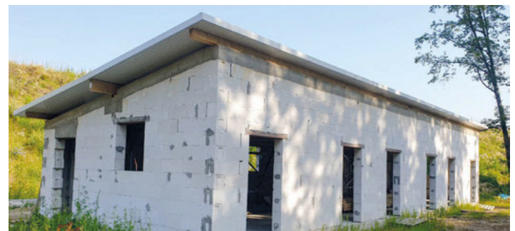
Der Rohbau des Großvolieren Haus - nun mit Dach.
