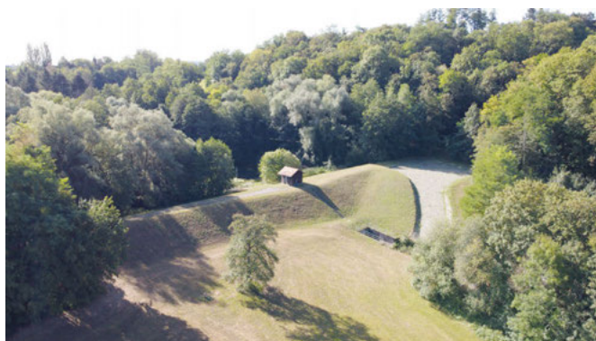
Hinter diesem Damm liegt das Rückhaltebecken
