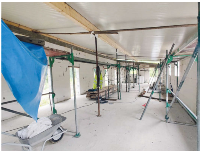
Innenansicht des neuen Vogelhauses beim Dach Bau.
