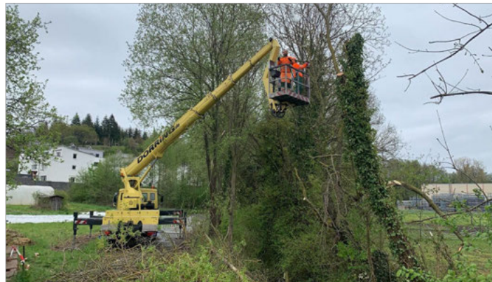
Verkehrssicherungsarbeiten am Walzbach
