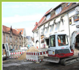
Update: Baustelle Jöhlinger Straße ab Seite 4
