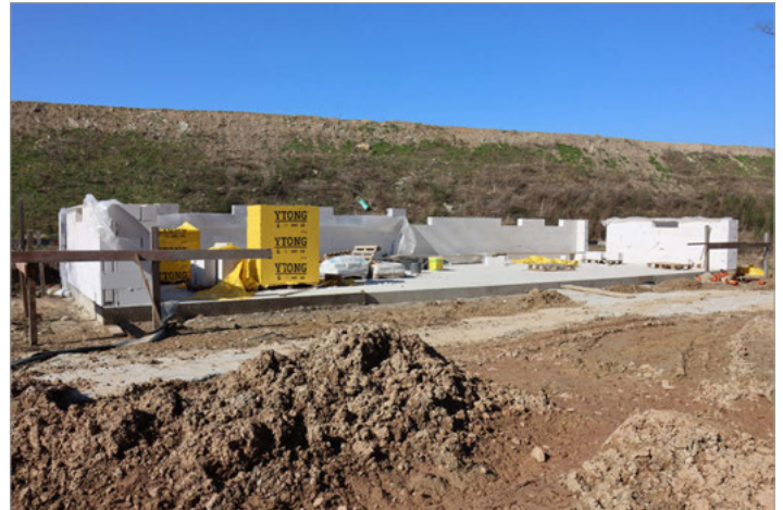
Bodenplatte und die ersten Wände unseres Großprojektes "Papageienhaus"
