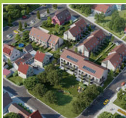
Waldbrücke: Baugebiet Ulmenplatz Seite 4
