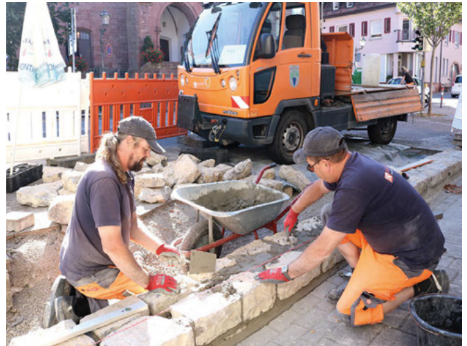
Gekonnt mauern Oliver Kraus (links) und Günther Hoffmann die weitestgehend naturbelassenen und lediglich gelegentlich etwas behauenen Steine zu einer kleinen Mauer, die die künftigen Parkplätze ansprechend begrenzen soll. Die leicht unebene Oberfläche ist bewusst gewollt.
