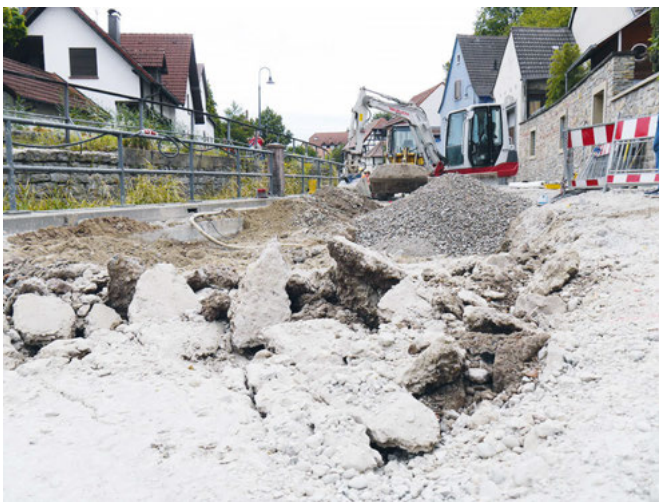
Jöhlinger Straße - Die Schottertragschicht wird für die Tiefbauarbeiten abgetragen.
