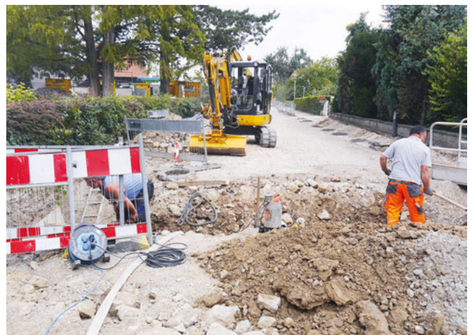
Silberstraße: Das Verlegen der Kanalrohre wird vorbereitet.
