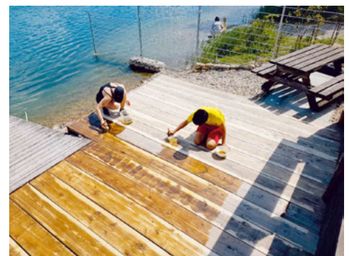
Die neue Beplankung der Plattform wird eingölt.
