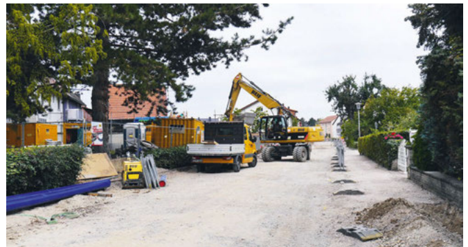
Tiefbauarbeiten in der Silberstraße
