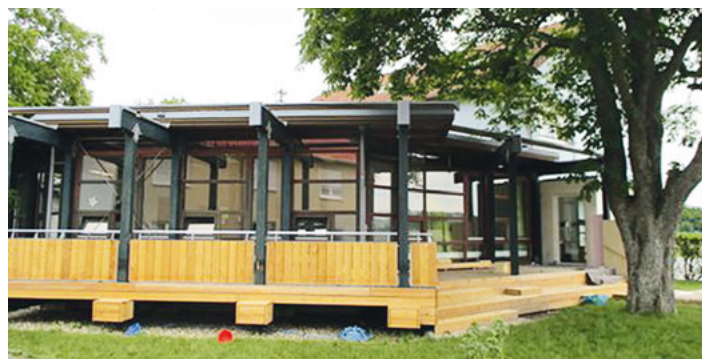
Gebäude Kindergarten am Buchenweg
