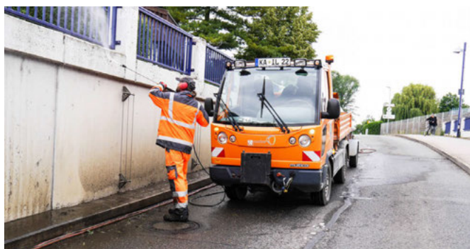
Bauhof im Einsatz: Auch die Seitenwände wurden grundgereinigt.
