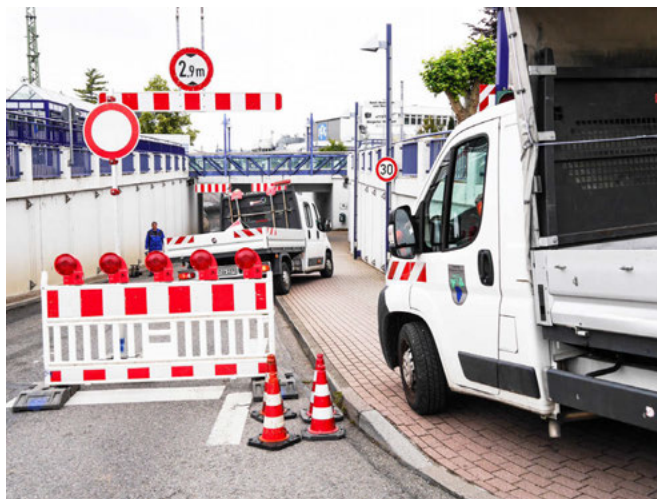
Die Unterführung war für die Arbeiten an zwei Tagen gesperrt.
