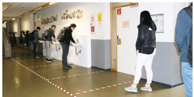
Die neu installierten Waschbecken im Souterrain ermöglichen öfters Händewaschen
