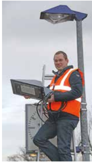
Tim Albrecht von der AVG-Instandhaltungsabteilung (Unternehmensbereich Infrastruktur) installiert an der Stadtbahnhaltestelle in Gernsbach Mitte die neuen energiesparenden LED-Leuchten (Foto: AVG/Michael Krauth; Abdruck honorarfrei).
