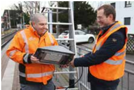
Alt gegen neu: Sven Zahn (l.) von der AVG-Bahnmeisterei Forbach und Tim Albrecht von der AVG-Instandhaltungsabteilung installieren die neuen energiesparenden LED-Leuchten an den Haltepunkten entlang der Murgtalstrecke (Foto: AVG/Michael Krauth; Abdruck honorarfrei).
