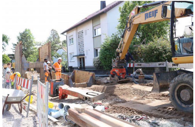
Arbeiten mit Stahl-Verbauboxen
