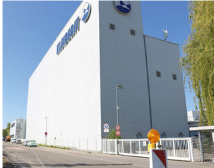
das bestehende HRL an der Max-Becher-Straße
