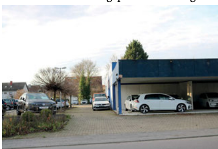
Der Standort d. ehem. Tabakshopfs und die ehem. Gebäude vom Autohaus Schlimm fallen unter den Bebauungsplan „Autohaus Schlimm“
