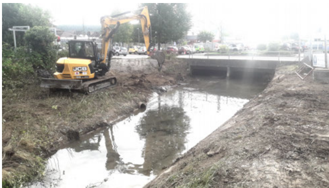
Günther Hoffmann hat mit dem Bagger sämtliches Gebüsch entfernt und den Bachauslauf wieder zugänglich gemacht
