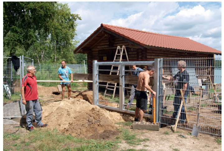
Arbeitseinsatz am 10.08.2019: Aufbau des Tores
