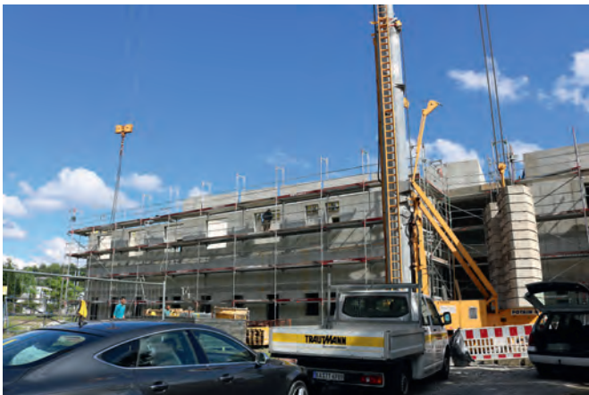
Fassade entlang der Kanalstraße
