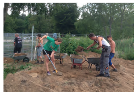
Arbeitseinsatz am 22.06.2019: Fleißige Schaufler beim Erdabtrag
