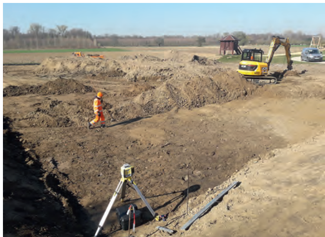
Riesige Erdmassen wurden bewegt und der Platz mit Vermessungstechnik nivelliert
