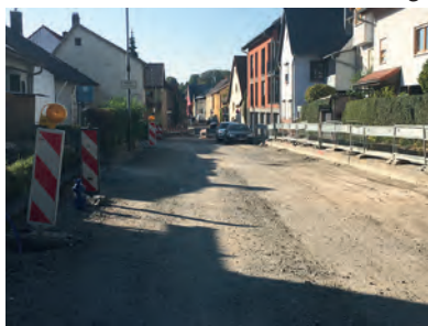
Erster Teilabschnitt der Sanierung Jöhlinger Straße (Foto sonntags)
