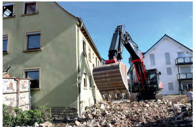
Zug um Zug schreitet die Erneuerung der Bausubstanz der genossenschaftlichen Häuser in der Mülberger Straße voran
