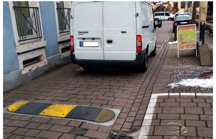
Hauswand, Rinnsal und Werbeschild zwingen Radfahrer, Rollstuhlfahrer und weitere Passanten die Schwelle zu passieren
