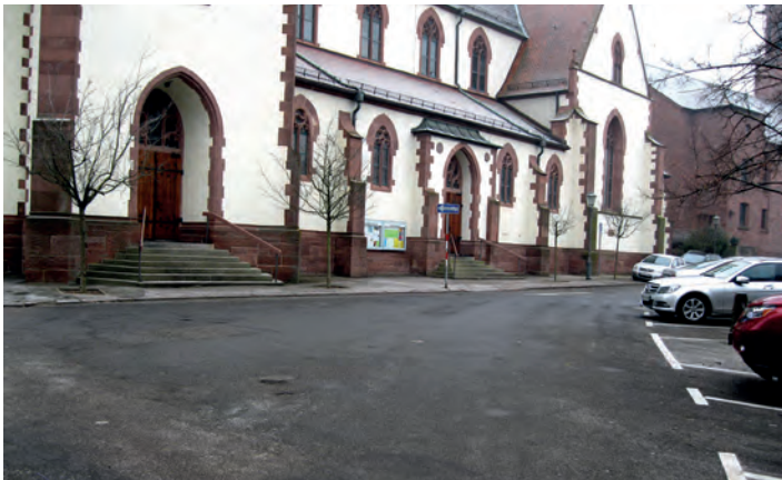
Der restliche Ausbau der Kirchstraße mit Neugestaltung des Kirchplatzes würde die dritte Großbaustelle in Weingarten sein. Foto: Daul
