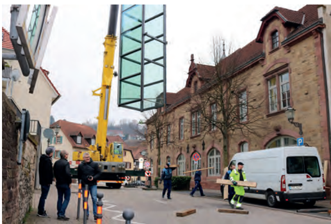
von der Vorderseite aus gesehen hievt der Kran den Schacht über das Rathausdach. Dazu wurde die B 3 am Samstagvormittag mehrere Stunden gesperrt
