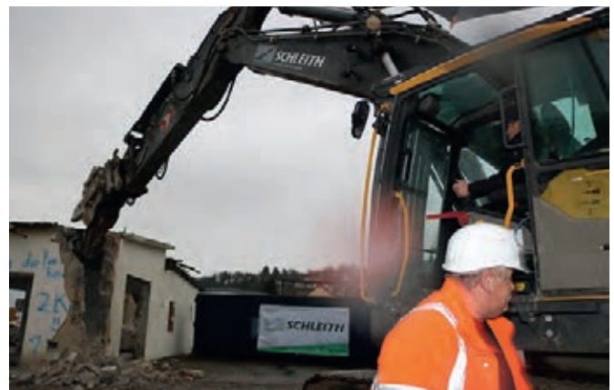
zahlreiche Gemeinderäte waren zur Baustelle gekommen, um mit Bürgermeister Bänziger den Startschuss zum Baubeginn „!mittendrin leben“ zu geben
