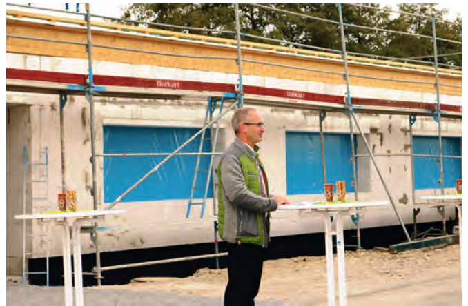
Richtfest am Bauhof. Das neue Personalgebäude steht im Rohbau.
