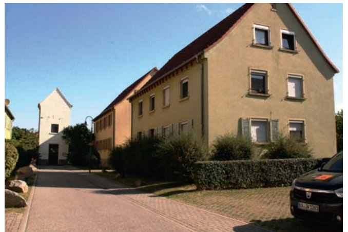
Eines der vier Häuser, die nach Fertigstellung des Neubaus sukzessive abgerissen werden sollen
