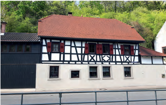
Das ebenfalls renovierte Fachwerkhaus Hoffmann in der Jöhlinger Straße gegenüber dem Gailbumber setzt einen besonderen Akzent im Ortszentrum.
