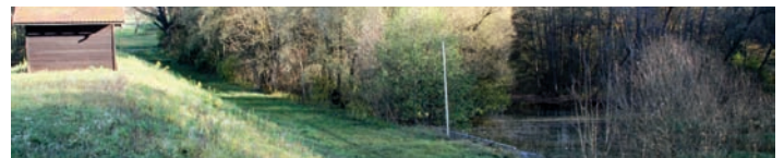
Die Sanierung des technisch überalterten Rückhaltebeckens „Am alten Schloss“ ist Teil einer umfassenden Hochwasserkonzeption.
