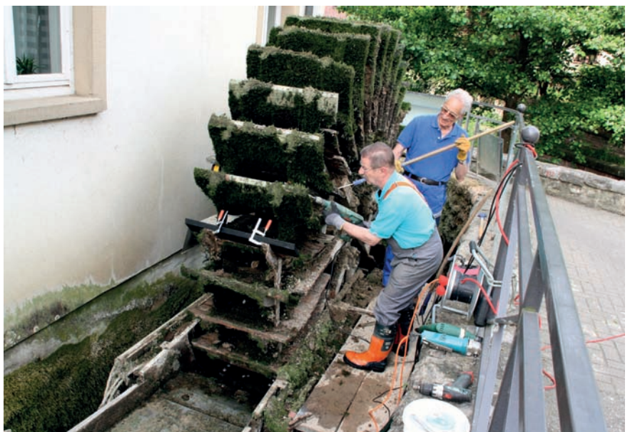
Karl-Heinz Hettler (vorn) und Winfried Schöffler entfernen mit Schaber und Bohrhammer die dicken harten Verkrustungen aus Kalk und Salz, die sich an den Radschaufeln ablagern
