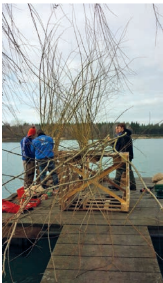
Bau der Reisigkörbe
