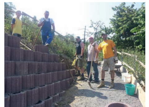
Arbeitsteam am Hangverbau
