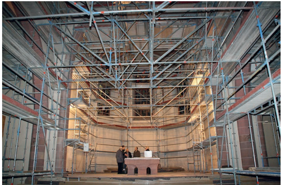
Ein monumentales Gerüst füllt die Kirche bis zur Decke
