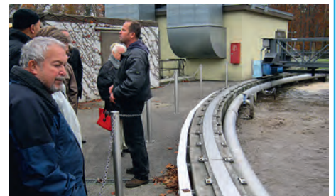
Der stellvertretende Klärwärter Jochen Satzke erklärt den Senioren am Belebungsbecken die biologische Reinigung der Abwässer. Fotos: prf
