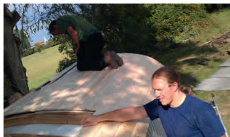
Rüdiger und Dieter reparieren das Dach
