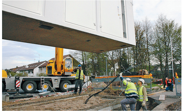
Ein Schwerlastkran hebt das 30 Tonnen schwere Verdichtergebäude und setzt es zentimetergenau auf das Fundament
