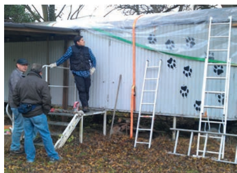
Provisorische Dachreparatur nach dem Sturmschaden
