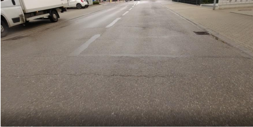
Neue Bahnhofstraße - Sanierung
