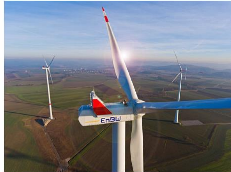
EnBW- Windpark Rot am See
