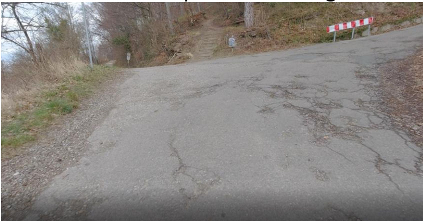
Zufahrt Köpfle - Sanierung
